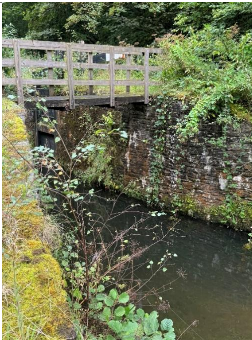
Delwedd 51 – Pont Loc Machin gyda choeden fêl yn tyfu ar un cynhaliad
