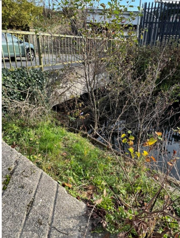
Delwedd 30 – Pont Stryd y Bont gydag uchdwr isel sy'n anaddas ar gyfer mordwyo
