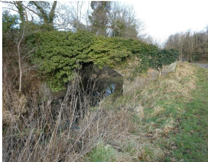
Delwedd 88 – Pont Maesgwyn
