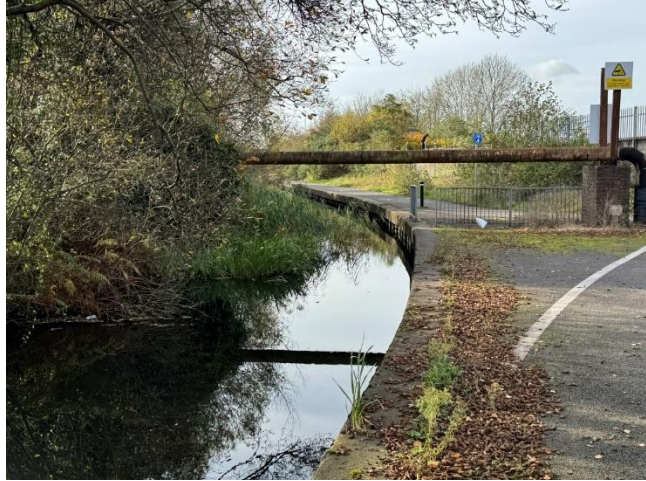
Delwedd 24 – Y Bont Bibell gyda'r tu allan wedi rhydu a chys yn rhwystro'r gamlas
