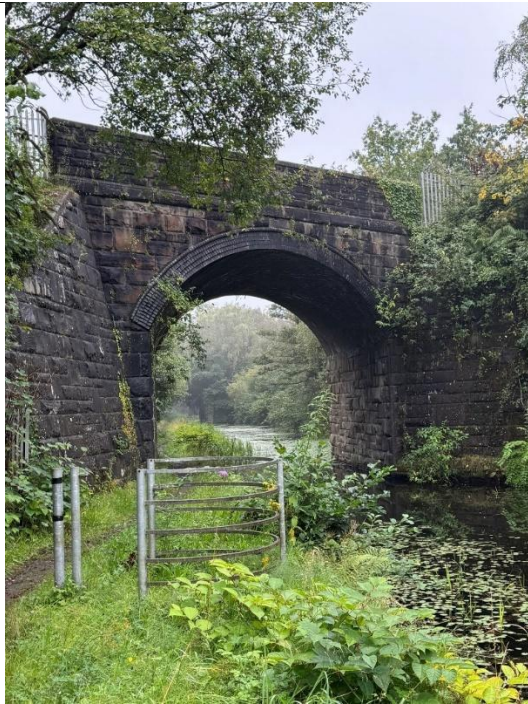
Delwedd 33 – Pont y Rheilffordd
