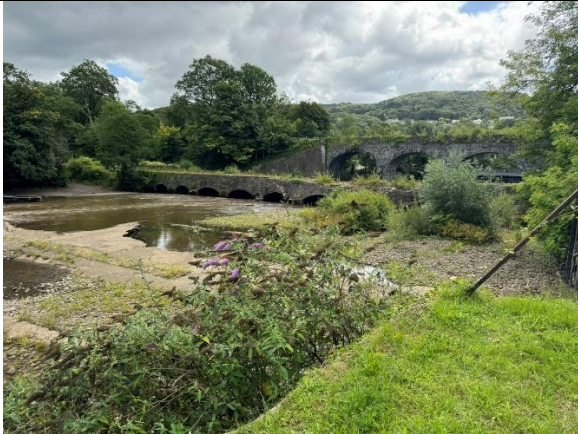
Delwedd 1 – Pont ddŵr Aberdulais
