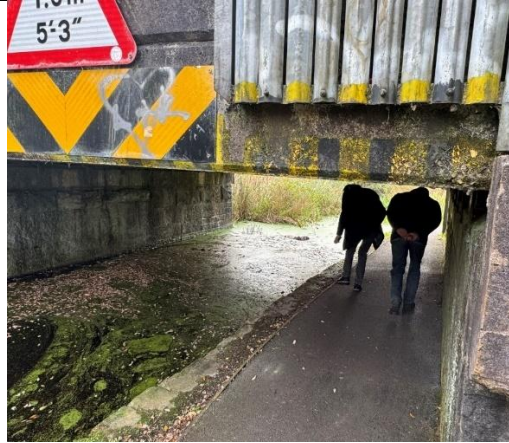
Delwedd 9 – Pont Reilffordd Cyffordd Castell-nedd, yn amlygu'r uchdwr isel (5'3) ar gyfer cerddwyr, er ei fod yn ddigonol ar gyfer mordwyo ar y gamlas
