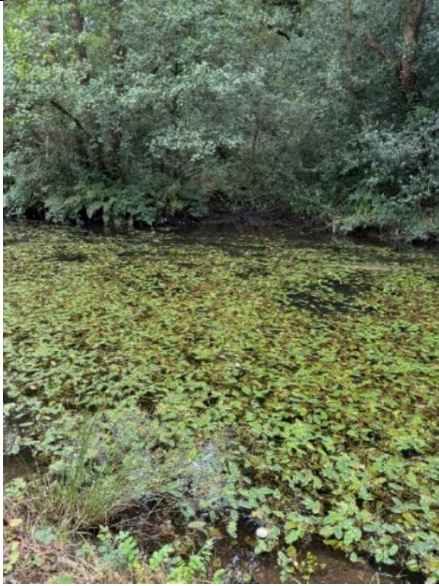
Delwedd 61 – Algâu/llystyfiant yn rhwystro'r gamlas ger Pont Abertwrch
