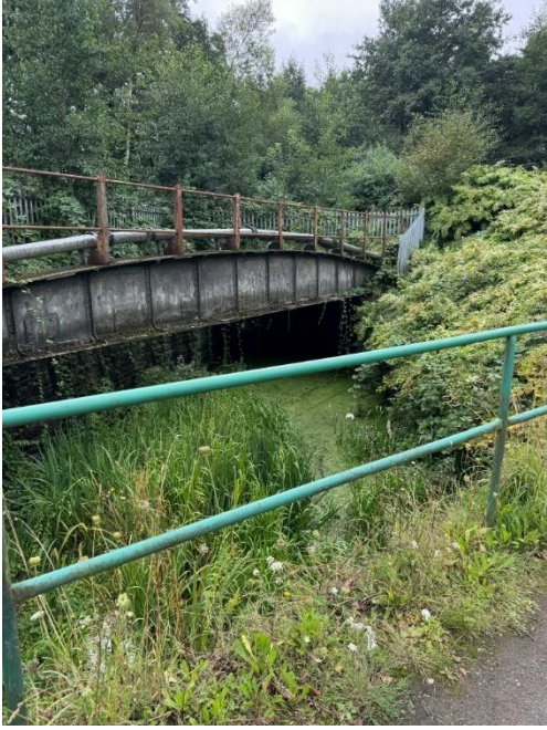
Delwedd 45 – Pont Rheilffordd Bro Nedd gynt
