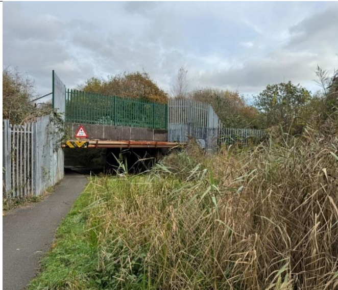
Delwedd 8 – Pont Reilffordd Cyffordd Castell-nedd, gyda'r gamlas yn llawn llystyfiant cyrs trwchus
