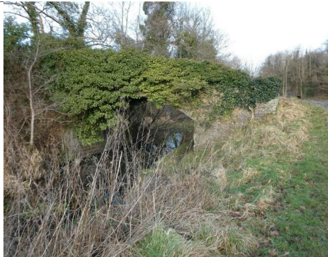
Delwedd 88 – Pont Maesgwyn
