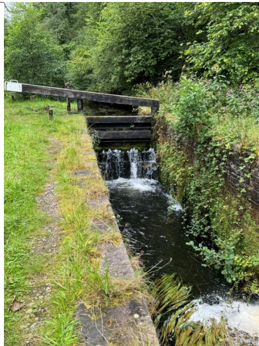
Delwedd 52 – Loc Machin gyda loc na ellir ei defnyddio
